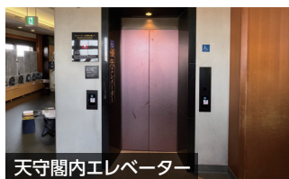
天守閣内エレベーター
