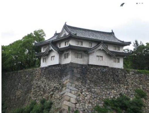
西外堀の外側から見た乾櫓
